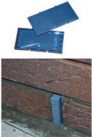
Рекомендуемая ширина воздушного зазора 100 мм. При использовании теплоизолатора расстояние от его поверхности к фасадной клинкерной кладки должно составлять 20–40 мм (рекомендуемое расстояние 40 мм).
